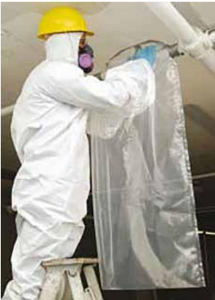
**BEST PLASTIKSÄCKE MIT VERTIKAL EINGEARBEITETEN HANDSCHUHEN** sind für alle vertikalen Rohrleitungen geeignet. Ohne Schweissnaht an der Unterseite des Sacks, ideal für Reparatur- oder Instandhaltungsarbeiten an kleinen Bereichen von Rohrleitungen oder Wärmedämmungen.
