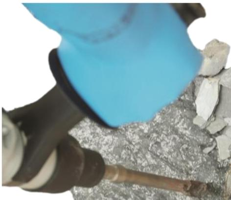
Die Verwendung von hochviskosem EGP GEL unter strikter Einhaltung der Einsatzbedingungen und des Betriebsverfahrens ermöglicht es Ihnen, eine Staubbelastung zu erreichen, welche unter der Gesundheitsgesetz-Richtlinie von 5 Fasern pro Liter liegt.
