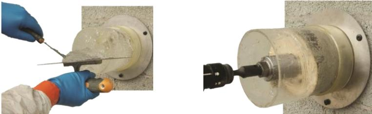
Die Verwendung von EGP GEL unter strikter Einhaltung der Einsatzbedingungen und des Betriebsverfahrens ermöglicht es Ihnen, eine Staubbelastung zu erreichen, welche unter der Gesundheitsgesetz-Richtlinie von 5 Fasern pro Liter liegt.
