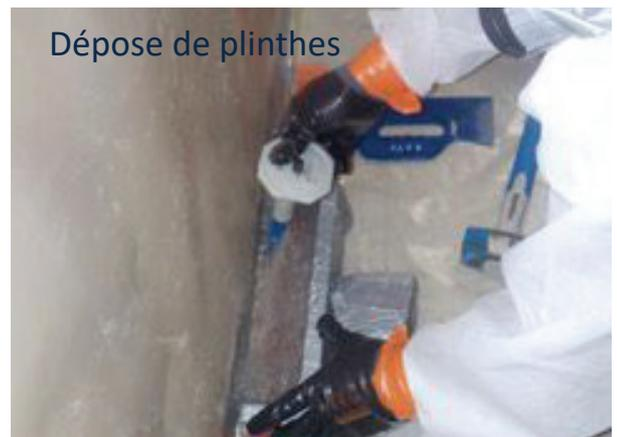
L'utilisation de l'EGP GEL haute viscosité dans le strict respect des conditions d'utilisation et du mode opératoire, vous permet d'obtenir un niveau d'empoussièrement inférieur au code la santé publique qui est de 5 fibres par litre.
