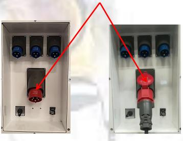
Positionner le sélectionneur **C** sur la position **2**
