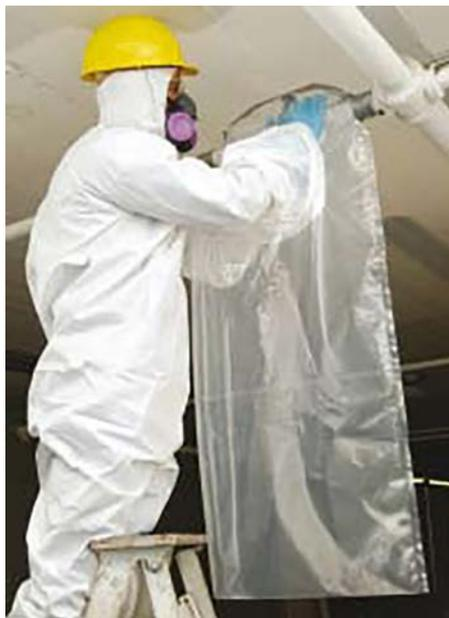
**BEST PLASTIKSÄCKE MIT VERTIKAL EINGEARBEITETEN HANDSCHUHEN** sind für alle vertikalen Rohrleitungen geeignet. Ohne Schweißnaht an der Unterseite des Sacks, ideal für Reparatur- oder Instandhaltungsarbeiten an kleinen Bereichen von Rohrleitungen oder Wärmedämmungen.
