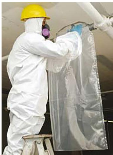
**SACS À MANCHE VERTICAUX BEST** adaptables sur toutes les canalisations verticales. Pas de soudure dans leur partie inférieure, idéal pour vos travaux de réparation ou de maintenance sur des petites sections de calorifuge ou de canalisation.
